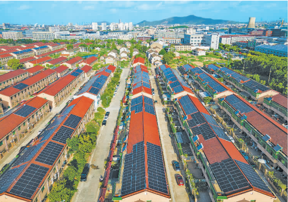
7月22日,走进江苏省江阴市周庄镇江东七村,只见农户屋顶上鳞次栉比的光伏板,宛如一片蔚蓝的海洋,绘就新农村建设绿色发展美丽画卷。近年来,当地供电部门积极推进农村分布式可再生能源开发利用,助力乡村全面振兴。 潘正光摄(中经视觉)
