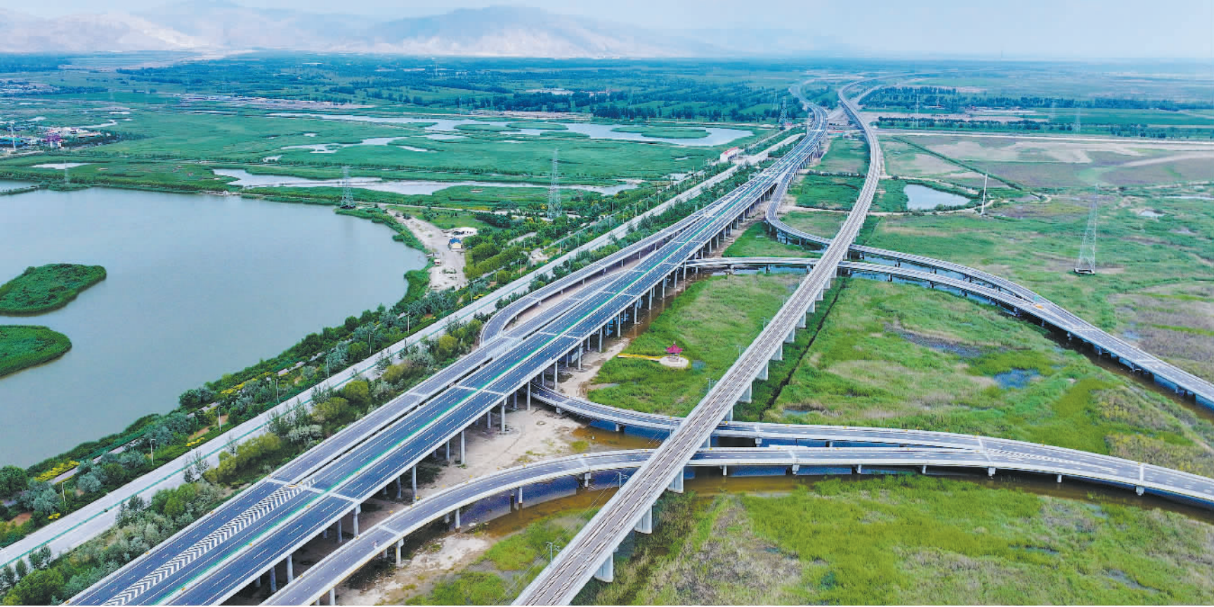
7月22日,乌海至玛沁公路(G1816)惠农至石嘴山段建成通车,标志着乌玛高速宁夏段全线贯通,将有效改善宁夏北部地区交通路网条件。这是当日拍摄的乌海至玛沁公路石嘴山段。
