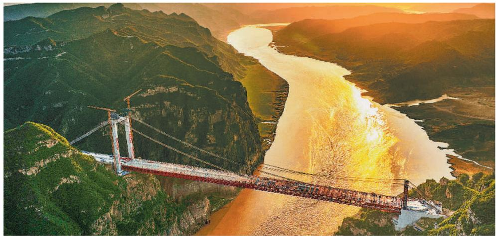
7月31日,河南省济新黄河大桥全桥贯通。该桥是世界首座地锚式回转缆索桥,是济新高速公路重点控制性工程,全长1688.5米,主跨555米。
