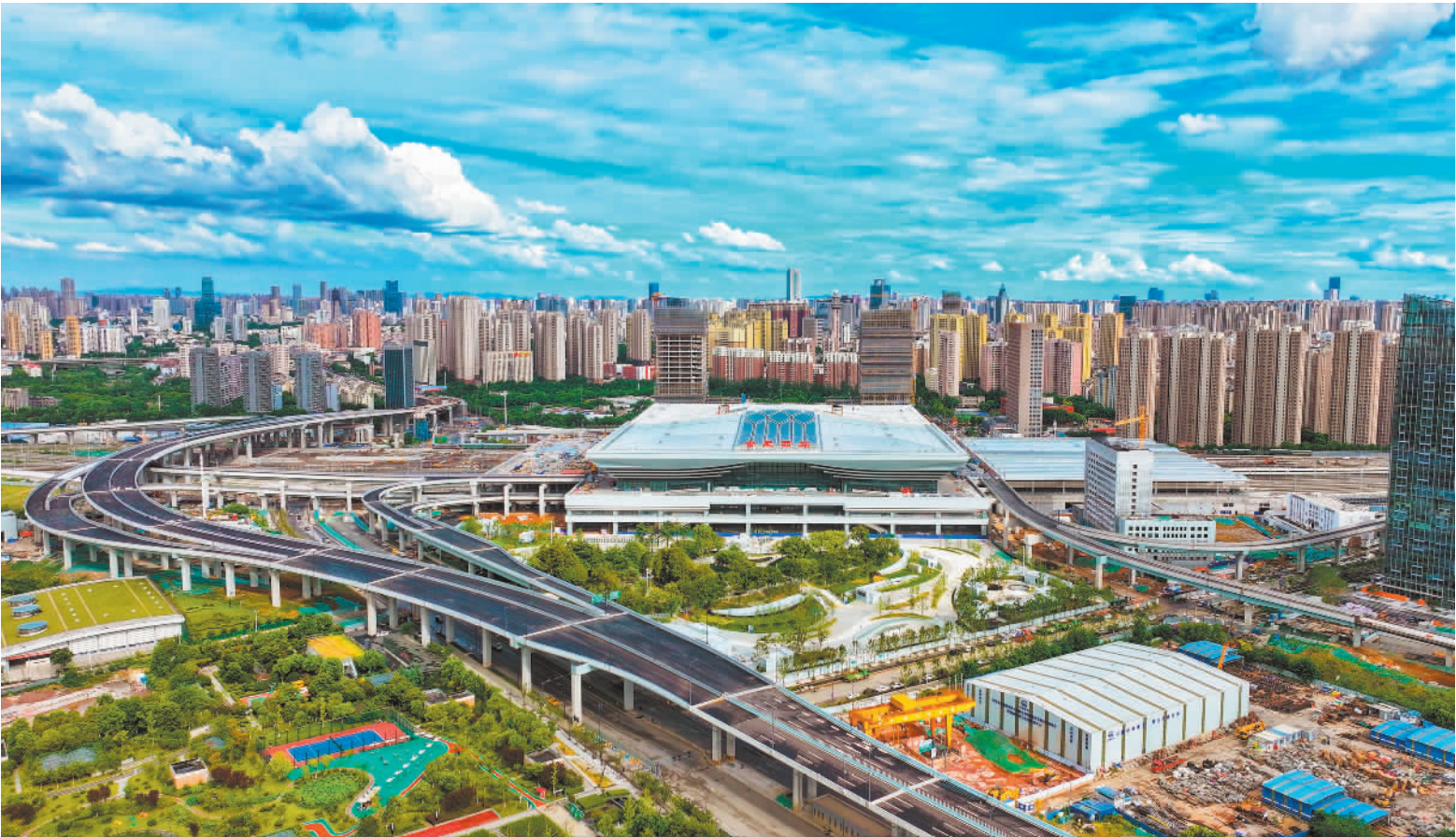
▼7月22日,安徽省合肥市合肥西站项目建设现场。该站集铁路客运、城市轨道交通、商业、市民休闲娱乐等功能于一体。 陈三虎摄(中经视觉)
