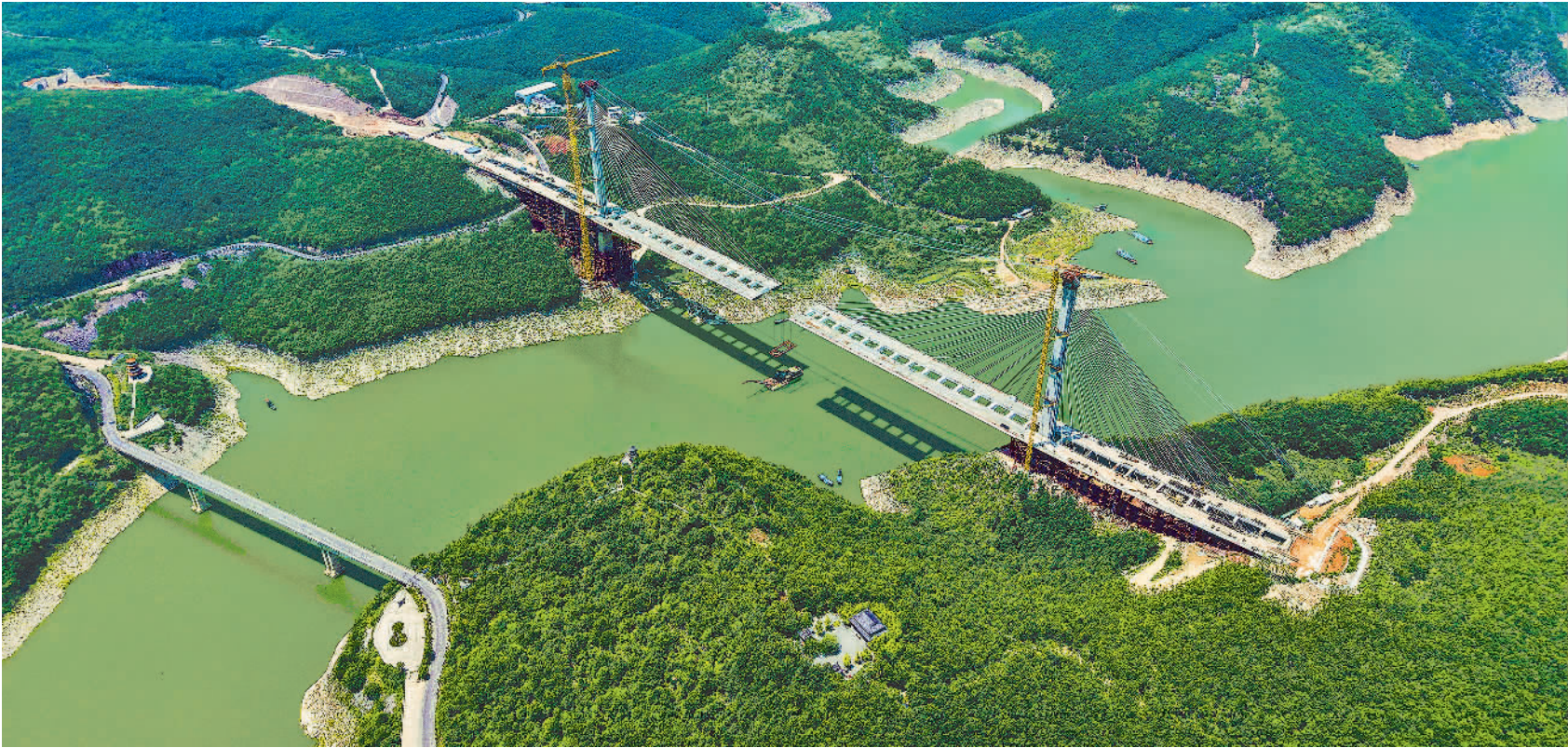
8月2日拍摄的河南省南阳市淅川县淅南高速丹江小三峡特大桥建设现场。项目建成后,将有效缓解沿线丹江口水库库区居民出行困难,开辟陕西、河南、湖北三省产业发展、人物流流新通道。
