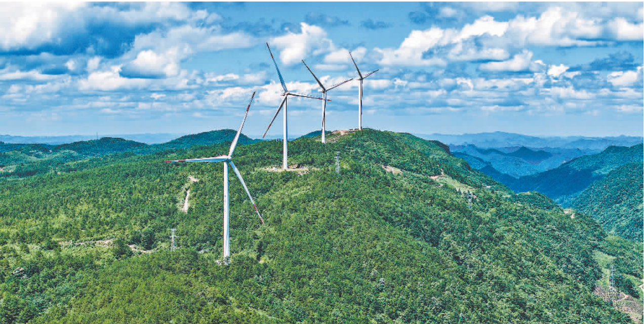
近年来，贵州加快构建新型综合能源基地，建设先进煤电机组，有序发展风电、光伏等新能源产业，推动建设西南地区电力枢纽，努力构建清洁低碳、安全高效的现代化能源体系。图为贵州龙里县的风力发电设施。
