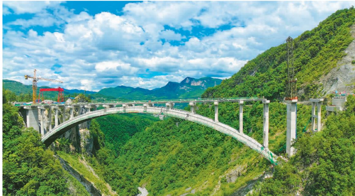
8月16日拍摄的湖北省恩施州野三关大桥建设现场。野三关大桥全长204.3米,于2024年3月开工,同年11月完成功能性骨架拱钢结构合龙。目前已全面转入桥面系施工阶段。
