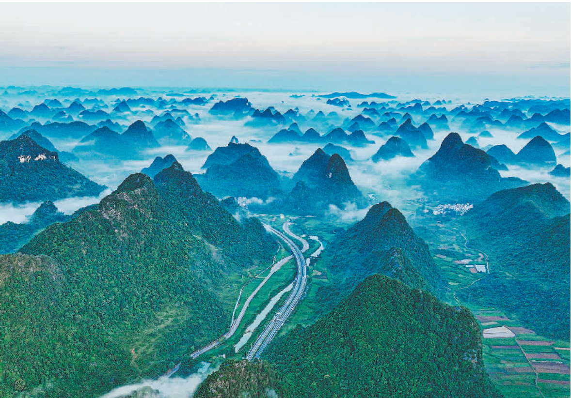
8 月 14 日拍摄的广西壮族自治区靖西市湖润镇，高速公路穿境而过。近年来，当地大力推进交通基础设施建设，补齐重点区域交通短板，不断满足群众出行需求。胡江涛摄(中经视觉)
