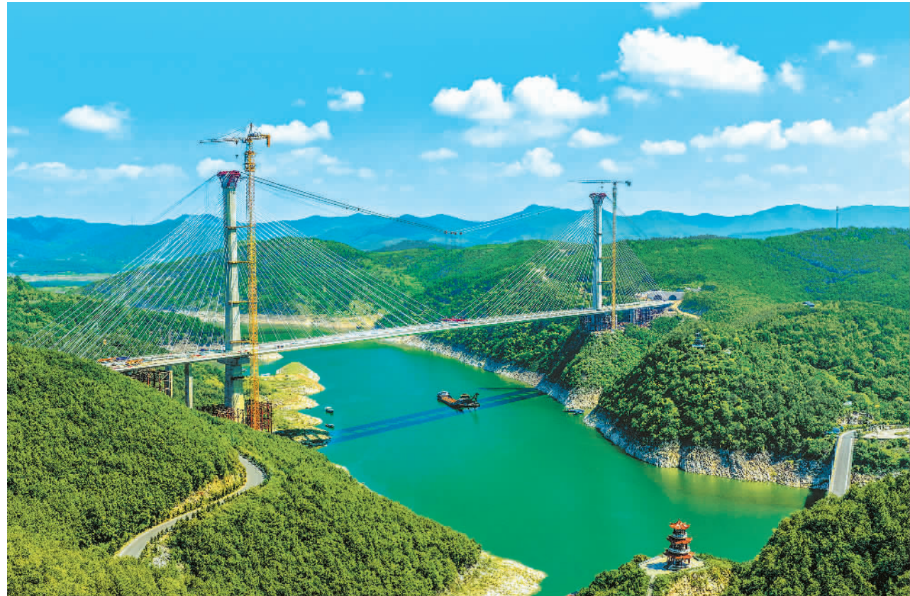
8月16日,河南淅浙(浉池—浙川)高速公路丹江小三峡特大桥桥面合龙。高速公路通车后,将有力促进河南、湖北、陕西三省之间的人员和经贸往来,进一步推动区域经济发展。 崔培林摄(中经视觉)
