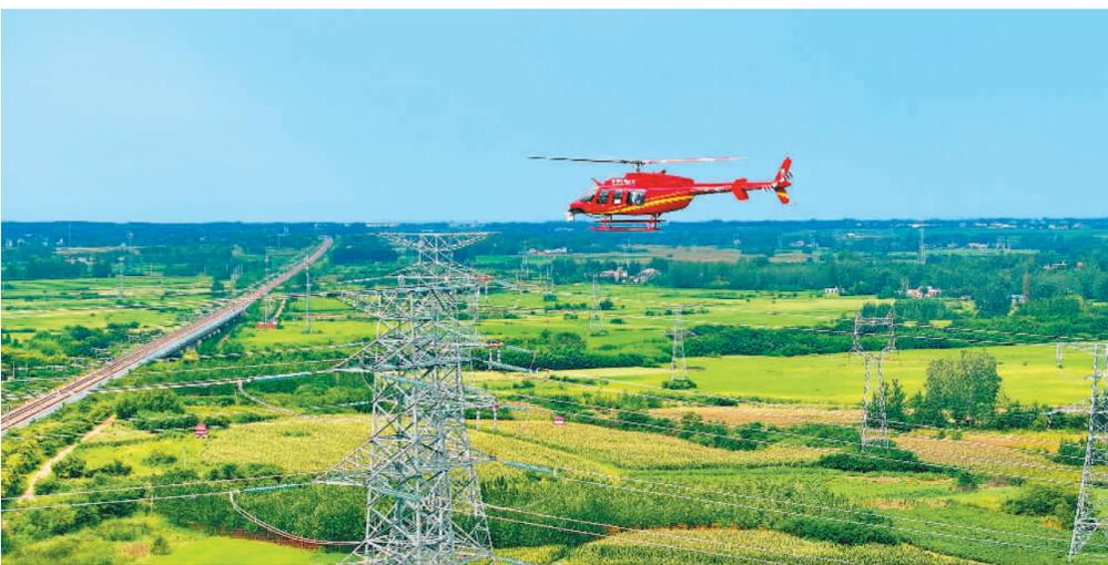
8月26日,安徽省滁州市定远县练铺村附近,国网安徽省电力公司利用直升机借助X光探伤和AI查缺技术对输电线路进行巡视检查,确保公共安全和电网安全。
