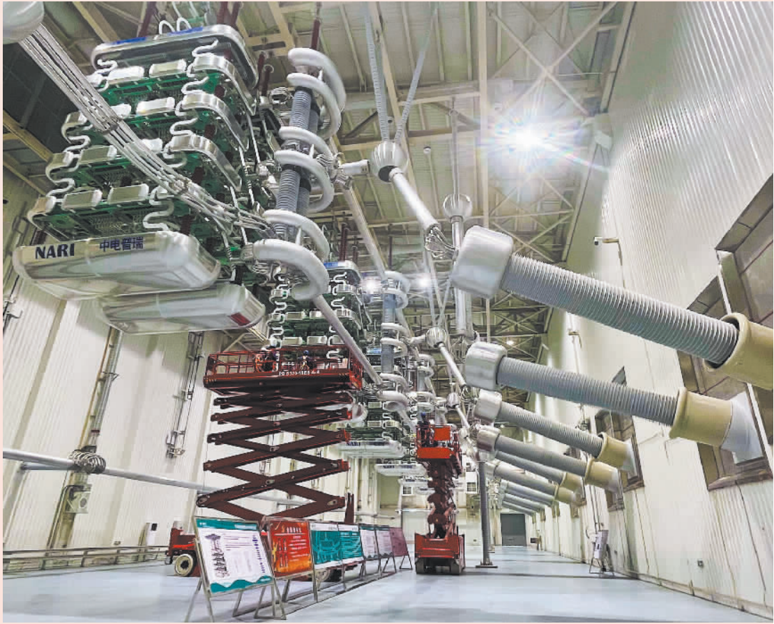
►5月17日,宁夏至湖南±800千伏特高压直流输电工程(“宁电入湘”工程)送端中宁换流站750千伏交流系统调试完成,带电投入运行。 乔瑞玲摄(中经视觉)
