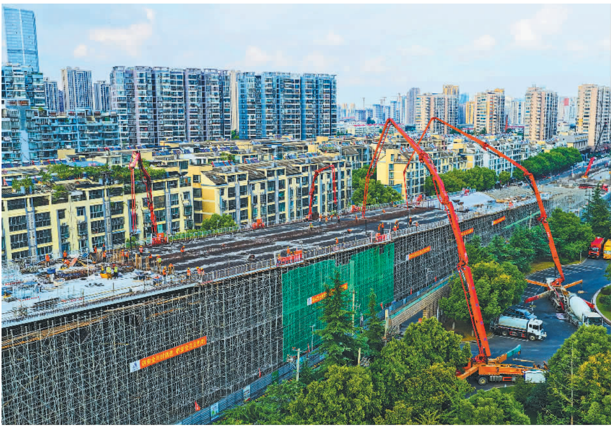
近日,安徽省合肥市清溪路高架项目现场,桥梁雏形已现,工人在开展混凝土浇筑作业。清溪路高架桥是新合肥西站的附属配套市政工程,建成后将与城市主干道紧密相连,为群众出行提供便利。张 敏摄(中经视觉)
