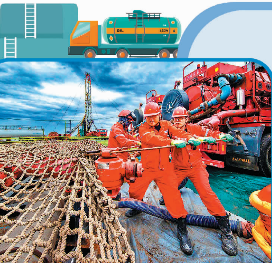
中国石油大庆油田施工人员对压裂设备进行调试与检查。吕殿杰摄(中经视觉)
