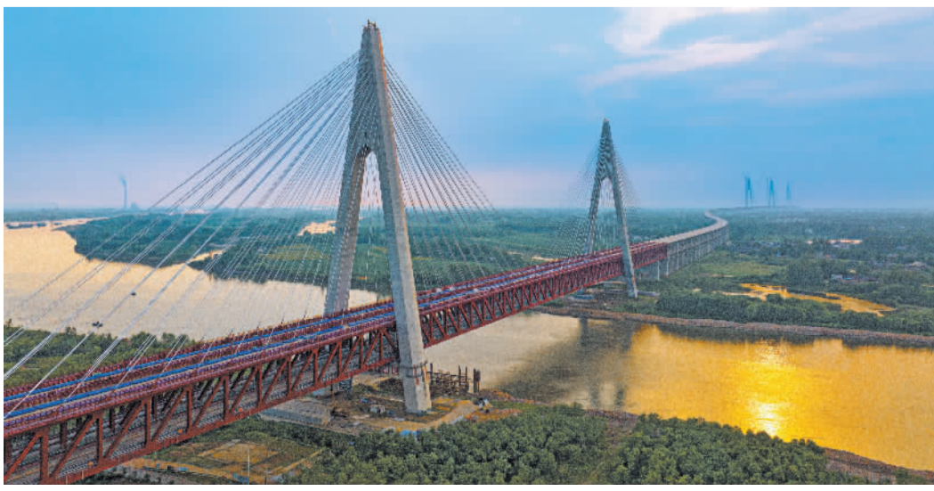
9月7日拍摄的安徽马鞍山巢马城际铁路马鞍山长江公铁大桥副汉航道桥建设现场。该城际铁路是国家“八纵八横”高铁网沿江通道的重要组成部分,建成后将进一步完善区域高铁网络布局。潘柳全摄(中经视觉)
