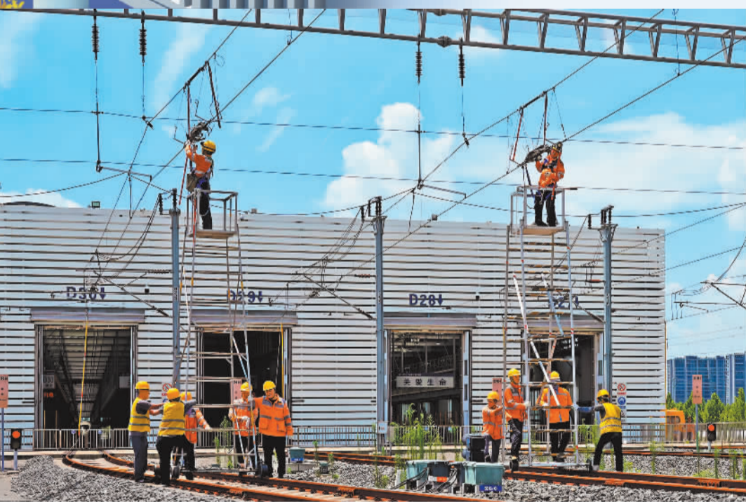
◀7月2日，上铁集团徐州供电段接触网检修工在高温下检修接触网设备，保障铁路供电安全。 李勇烁摄(中经视觉)
