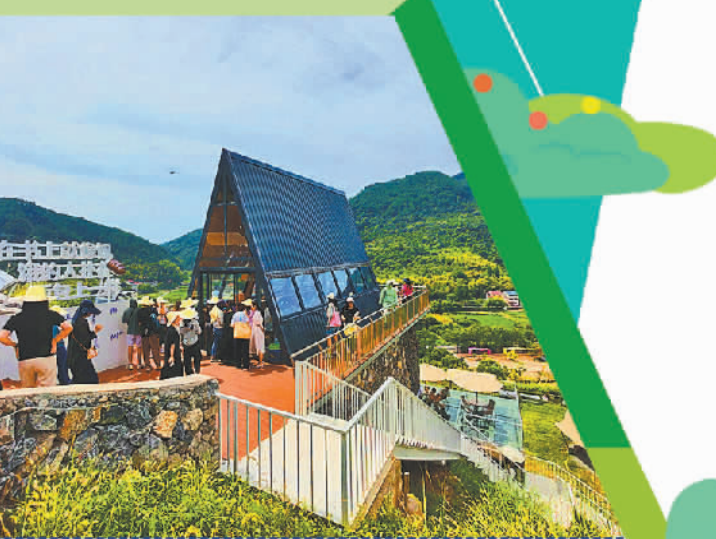
浙江衢州常山县路里坑村将废石灰窑改建成“窑书房”。 本报记者 李 景摄
