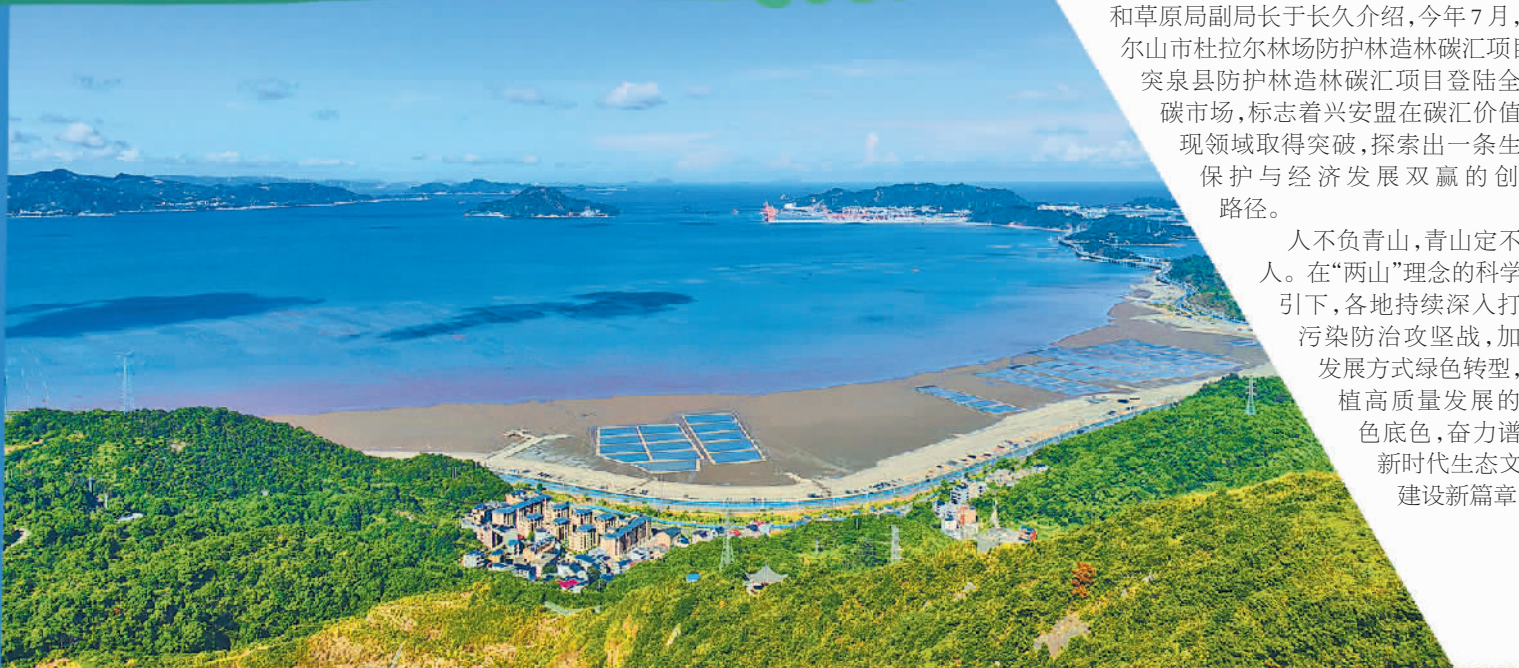
在浙江温州洞头岛,国网温州供电公司打造海岛型高可靠微电网集群,提供绿色电能。 本报记者 李 景摄
