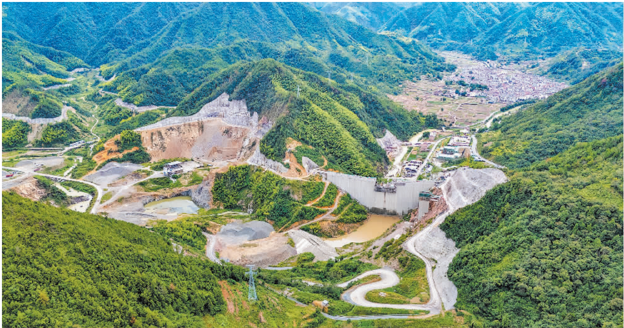
9月10日,浙江省金华市磐安县,好溪水利枢纽流岸水库大坝顺利封顶。该工程以供水、防洪为主,兼顾发电、改善水环境功能,建成后将提升好溪流域防洪标准,优化区域水资源配置,为浙中地区经济发展提供坚实水利支撑。
