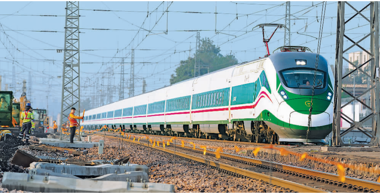
9月13日,中国铁路郑州局集团有限公司郑州桥工段职工利用210分钟施工“天窗”,对京广铁路新郑站下行进行机械化轨枕更换作业。图为职工在立岗迎车。 曹 源摄(中经视觉)
