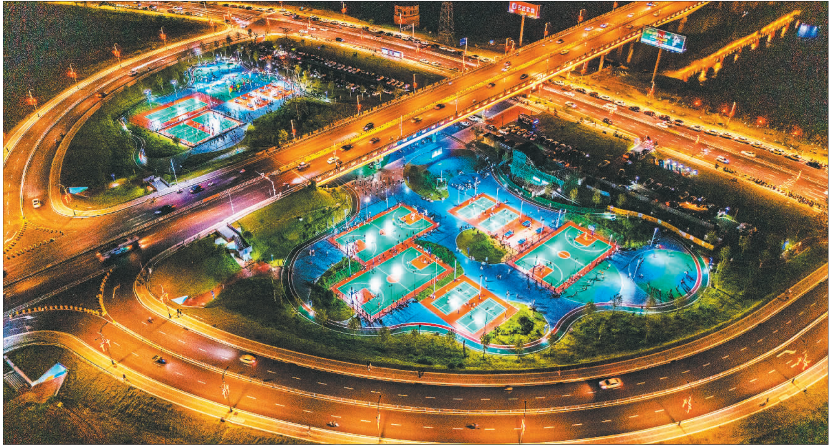
▼8月23日拍摄的湖南省永州市冷水滩区湘江体育公园夜景。该公园充分利用桥下空间建设,与道路、桥梁共同构成一道独特风景线。 雷中祥摄(中经视觉)
