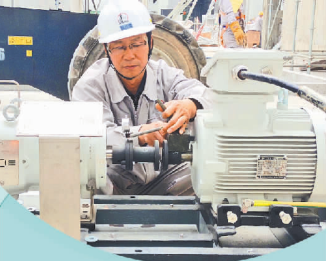
钱百能在精心调试石油化工设备。
