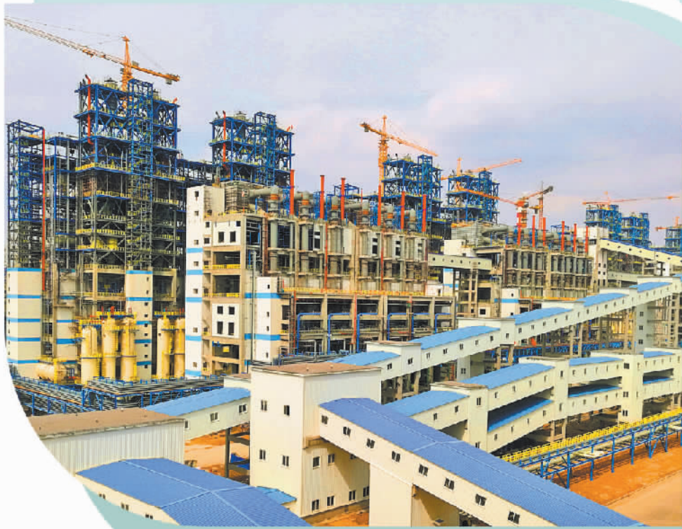
中石化四建公司参建的神华集团宁夏煤化工生产装置。
