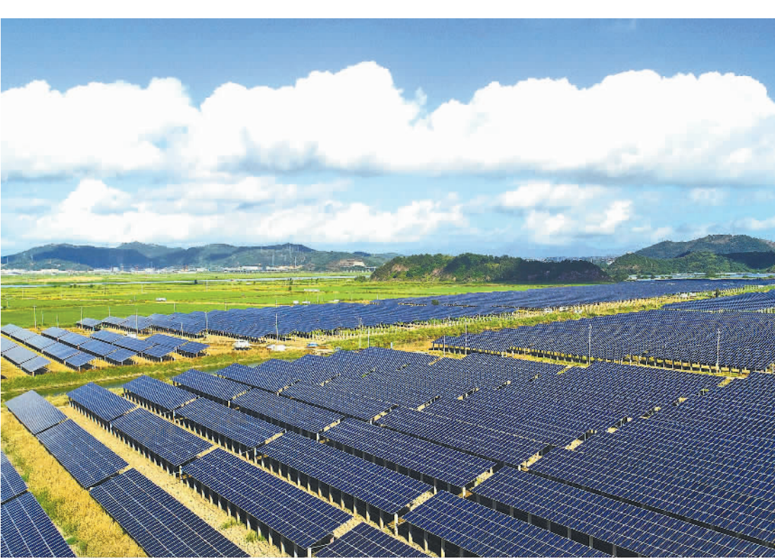
秋阳高照，浙江省玉环市漩门三期滩涂地上，光伏方阵依次排列，碧绿农田整齐成方。近年来，当地将6万多亩滩涂逐步开发成农业区块、工业区块、城市区域，提高土地利用效益，推动实现“赋能融合，聚力共赢”发展目标。
