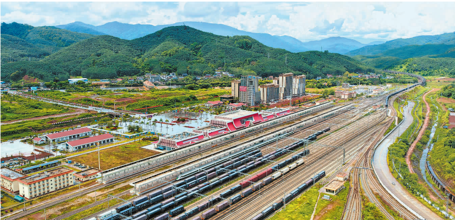
9月21日,中老铁路货运列车在云南磨憨站通过(无人机照片)。截至9月19日,中老铁路全线累计开行货物列车突破6万列,货运量超6760万吨,其中跨境货物运输突破1500万吨。
