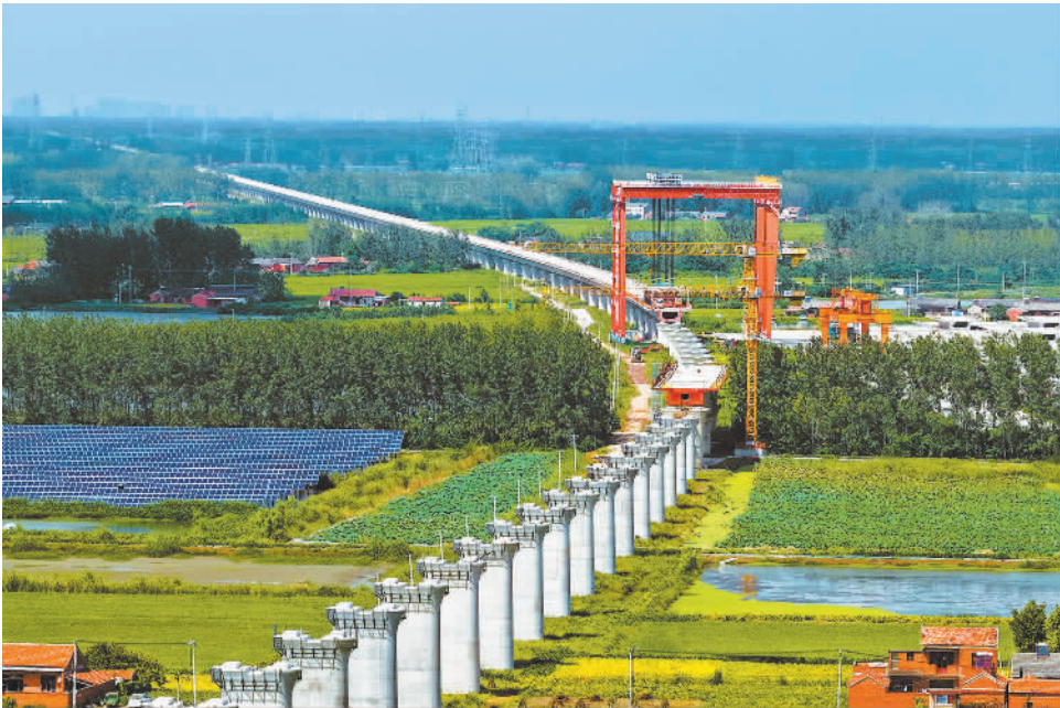
9月22日，江苏省淮安市，工人在宁淮城际铁路（洪泽段）项目现场施工。宁淮城际铁路是长三角城际铁路网的重要组成部分，建成后南京与淮安将实现1小时直达，在方便沿线人民群众出行、推动区域协调发展方面具有积极作用。（殷潮摄（中经视觉））
