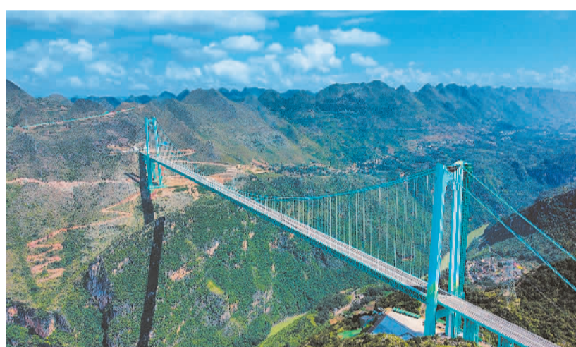
9月28日,贵州花江峡谷大桥建成通车。该桥全长2890米,主跨径1420米,是目前世界山区峡谷第一大跨度钢桁梁悬索桥;其桥面距水面垂直高度625米,位居世界第一。杜朋城摄(中经视觉)
