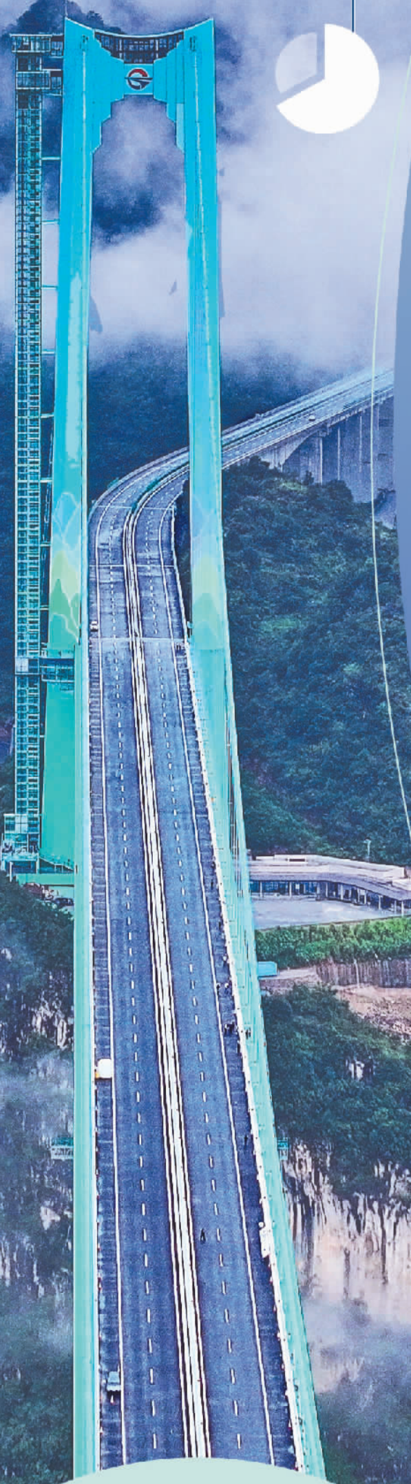
贵州花江峡谷大桥是贵州六枝至安龙高速公路的控制性工程,是新的世界第一高桥。 新华社记者 杨文斌摄
