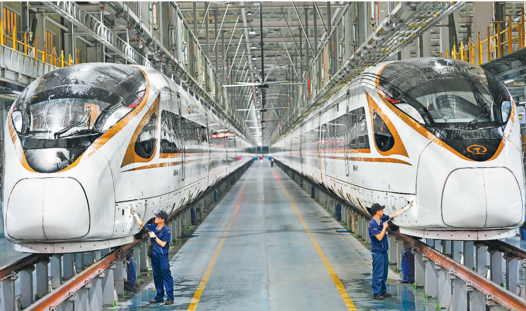
车间进村拓宽就业路。图为月湖区童家镇工业园区，东动车段南京南动车运用所检修库，地勤机械师在检修动车，确保动车设备正常，守护国庆、中秋假期出行安全。
