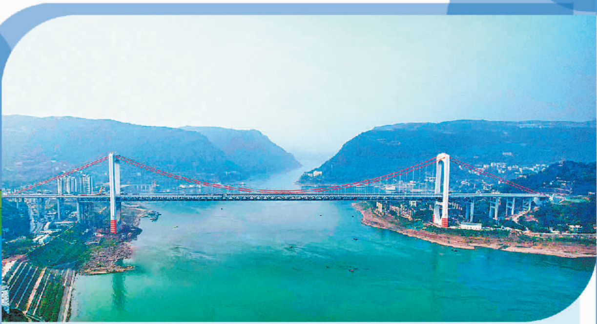
由中建六局承建的重庆郭家沱长江大桥。
