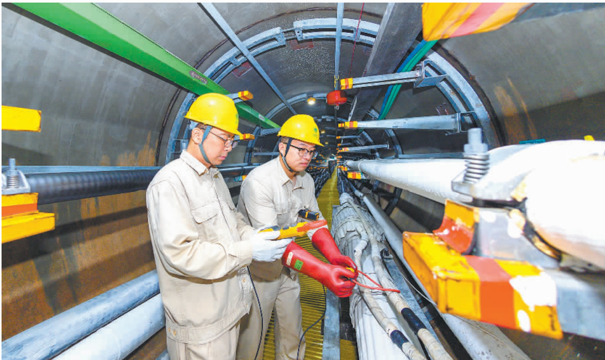
在为南京南站供电的220千伏善南—南牵线电缆隧道内,国网南京供电公司工作人员在对线路进行巡检。
