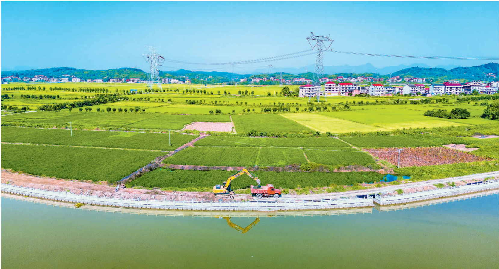
10月16日,湖南省娄底涟源市杨市镇金盆村孙水河段,施工车辆在清理渣土。近年来,涟源市持续推进生态修复,全力打造“河畅、水清、景美”的生态环境,谱写人与自然和谐共生的生动篇章。 吴永华摄(中经视觉)
