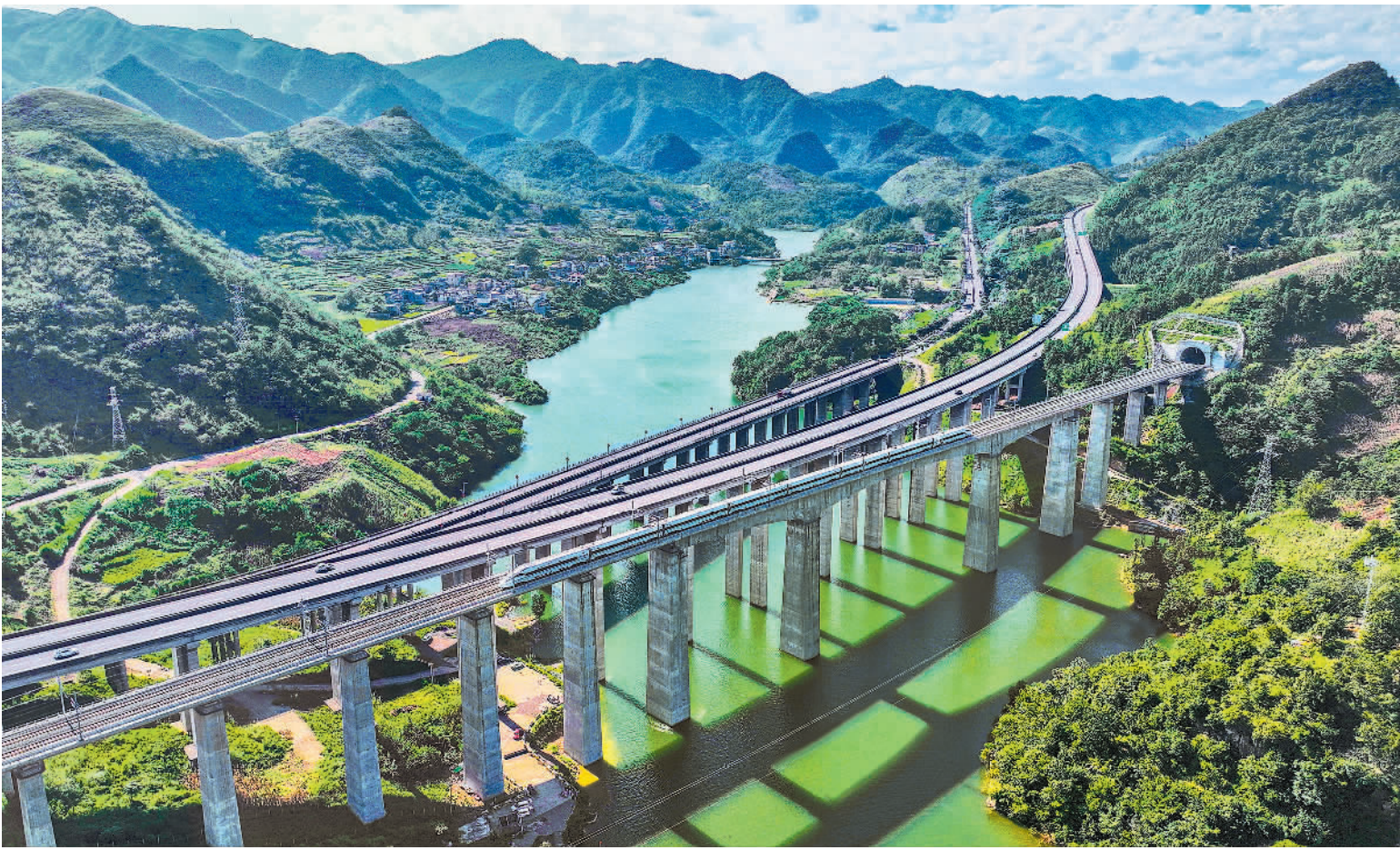
10月17日,盘兴高铁运行试验列车经过贵州省黔东南州兴义市清水河镇纳怀河特大桥。目前,盘兴高铁进入运行试验阶段,线路即将开通。盘兴高铁设计时速250公里,建成通车后对完善区域铁路网布局,促进当地经济发展具有重要意义。 刘朝富摄 (中经视觉)
