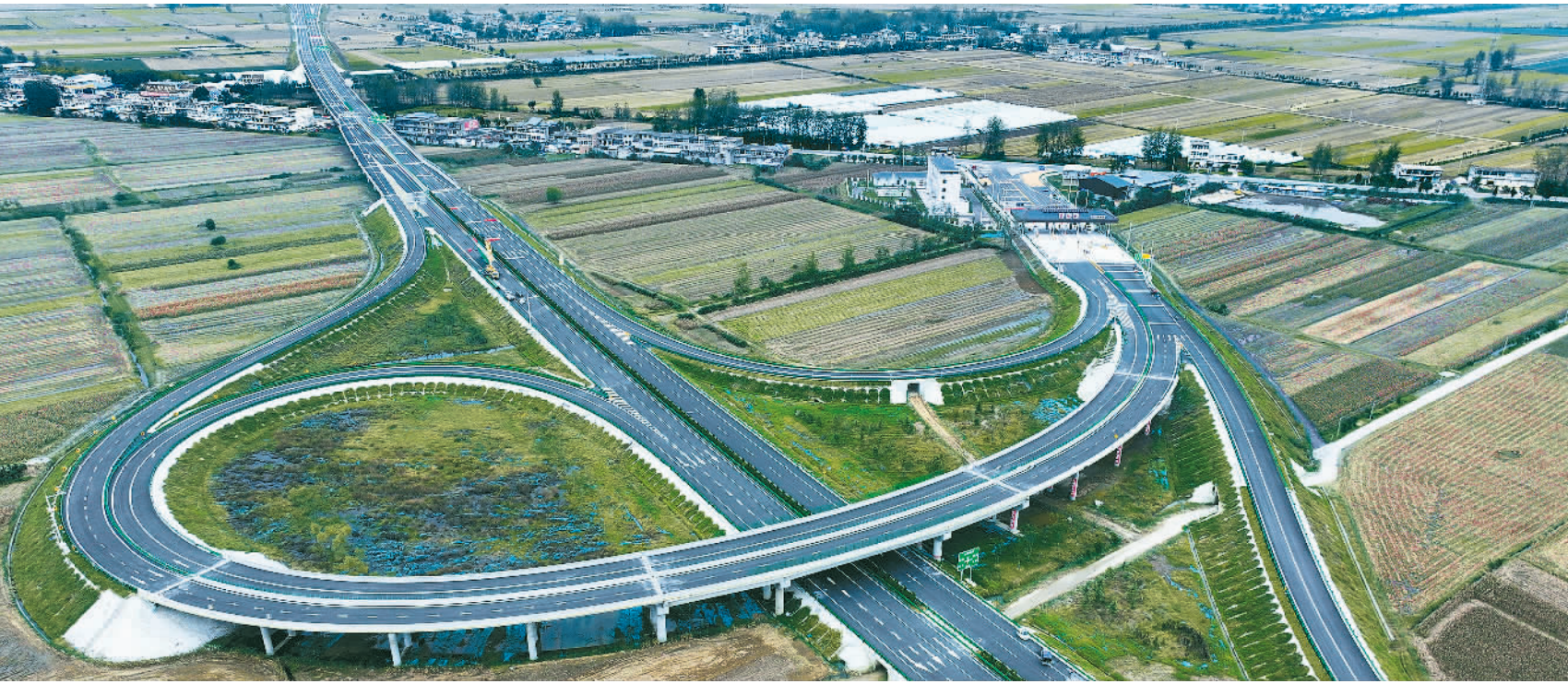
10月19日，安徽省亳州市蒙城县五蒙高速施工现场，工人正在开展道路相关工程扫尾施工。目前，五蒙高速全线主要关键性节点全部建成，预计今年底通车。五蒙高速建成后，将进一步完善皖北高速公路网布局，助推区域经济社会高质量发展。
