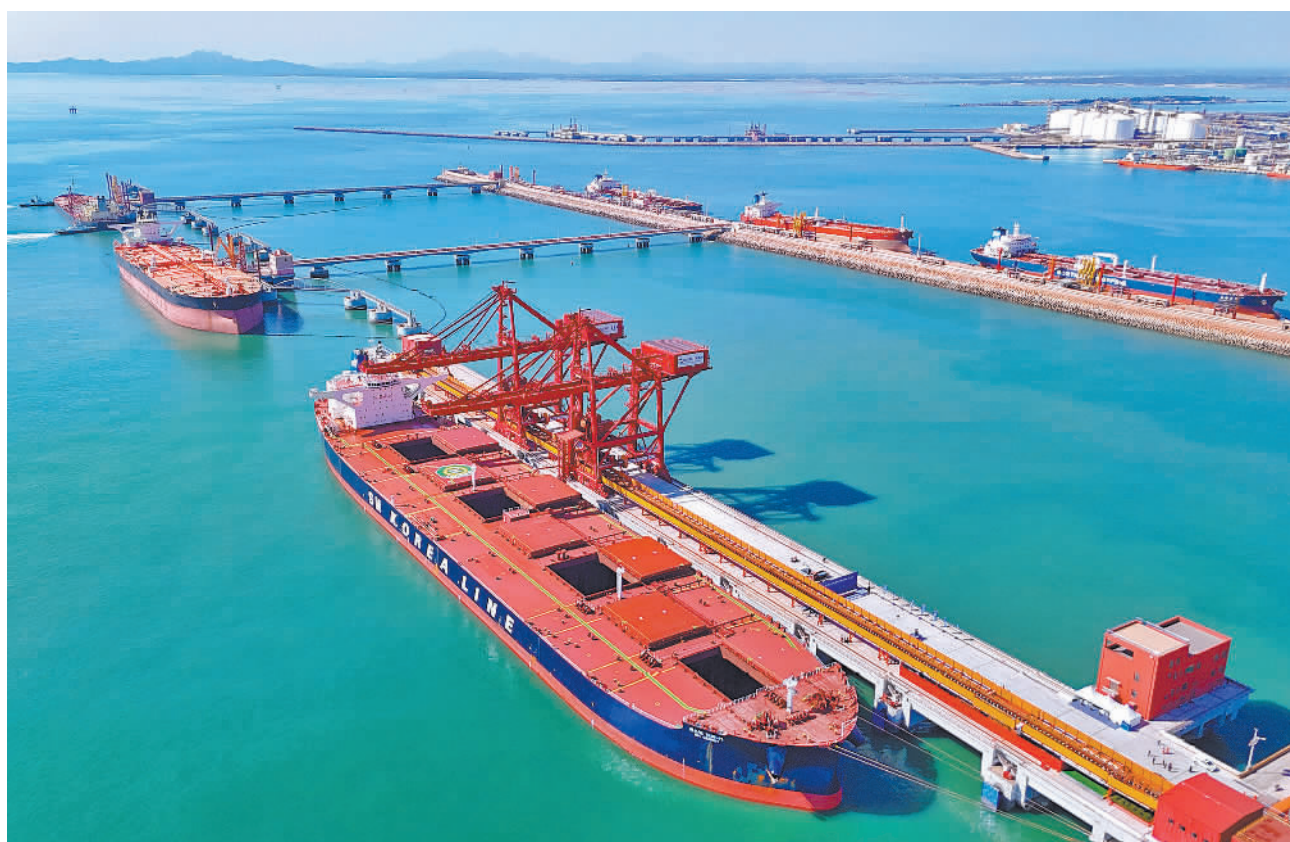
10月27日在山东青岛拍摄的山东港口青岛港第二座40万吨矿石码头。当日,山东港口青岛港第二座40万吨矿石码头投产。这也是全国首个40万吨干散货数智码头,集成5G、人工智能、云计算等前沿技术,率先开发应用智能化的干散货码头通用操作系统,将实现全流程生产经营过程的实时监测、智慧决策和数字化感知。张进刚摄(新华社发)
