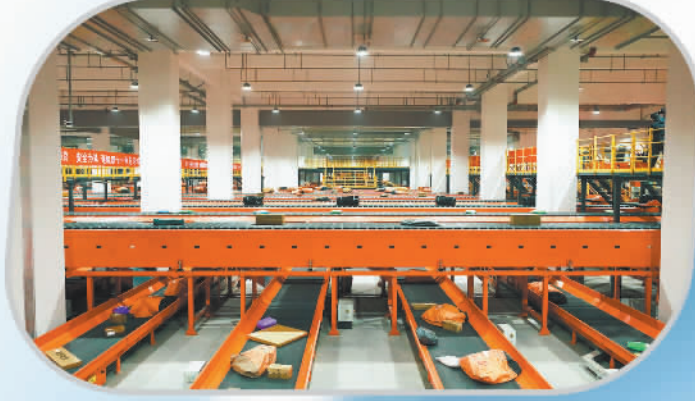
位于河北省永清县的中通快递北方总部基地二期项目正在运行的快速分拣线
