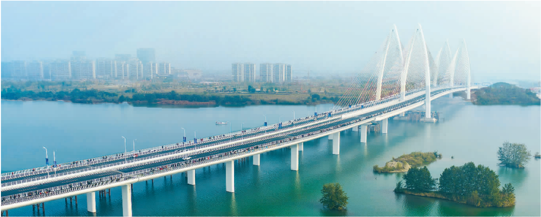
11月24日,位于四川省遂宁市的涪江六桥正式通车,车辆与行人正在通过大桥。该桥连接遂宁河东新区与老城、高铁新城片区,通车后将缓解过江压力,促进区域协调发展。 刘昌松摄(中经视觉)
