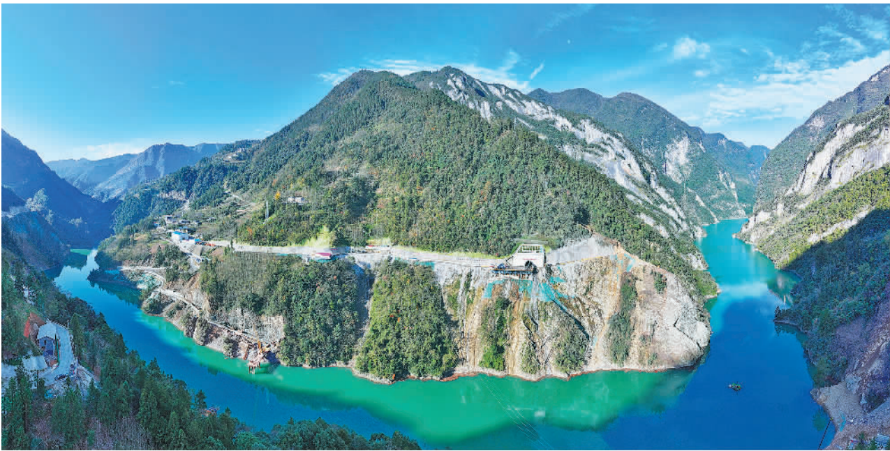
11月23日，位于湖北省恩施土家族苗族自治州新塘乡的宜涪高铁（宜昌至涪陵）顶坪隧道、木果园村隧道施工现场，工程建设正在紧锣密鼓推进。宜涪高铁是国家“八纵八横”高铁网中沿江通道的重要组成部分，对完善区域交通网络、促进长江经济带发展具有重要意义。 张远明摄（中经视觉）
