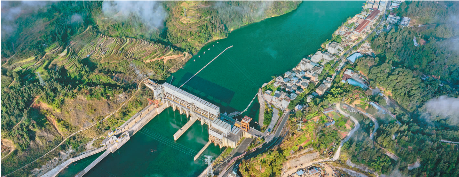
11月29日拍摄的贵州省从江县都柳江从江航电枢纽。近年来，当地积极推进生态文明建设，依托都柳江流域的水资源优势，大力发展水电清洁能源，推进绿色低碳发展。
