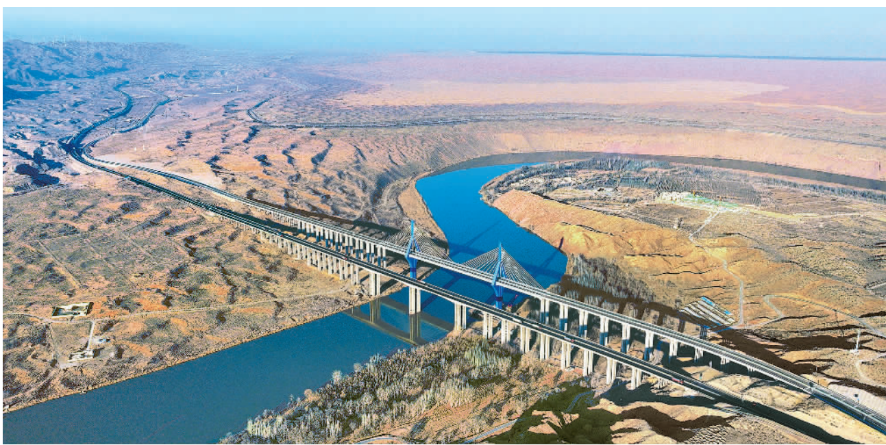
12月27日,俯瞰位于宁夏中卫市沙坡头区的黑山峡黄河特大桥。近日,该大桥主体工程基本完工,即将建成通车。项目建成后,将进一步完善西北地区公路网络。 袁宏彦摄(中经视觉)
