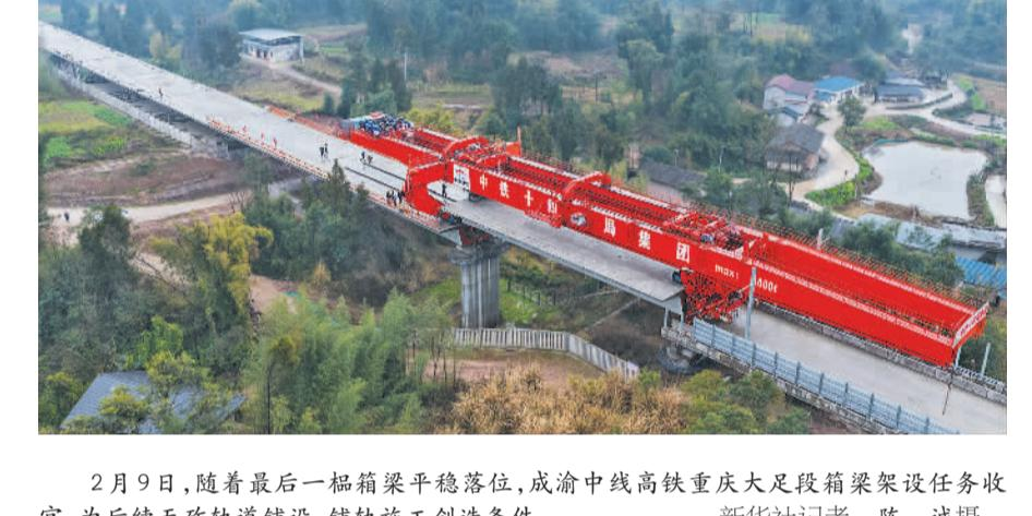
2月9日，随着最后一榀箱梁平稳落位，成渝中线高铁重庆大足段箱梁架设任务收官，为后续无砟轨道铺设、铺轨施工创造条件。新华社记者 陈诚摄
