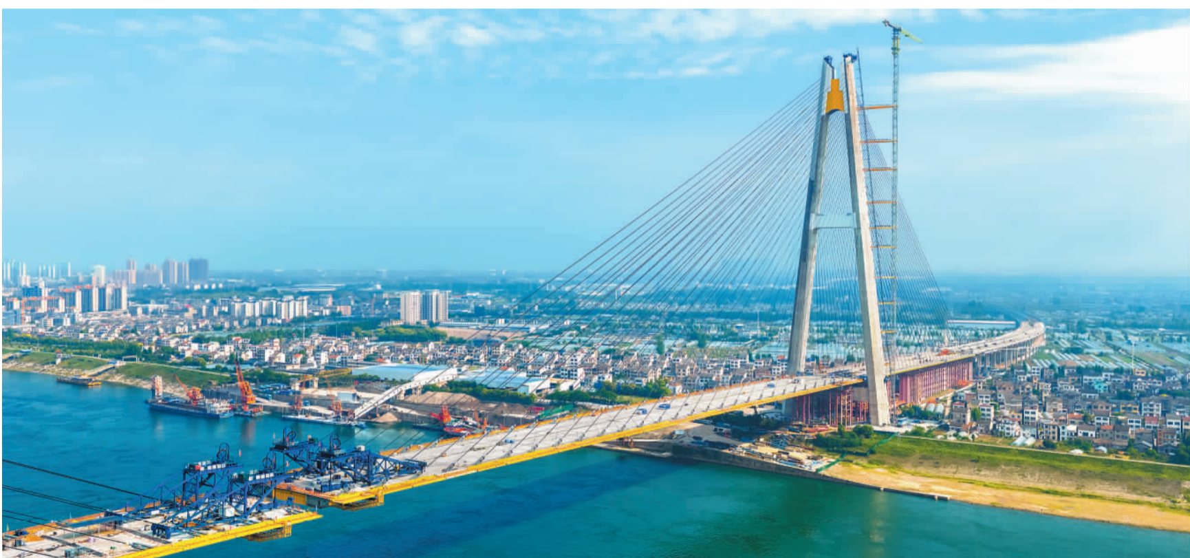
5月1日,湖北枝江长江大桥施工现场一派繁忙,全桥仅剩一个合龙段吊装,施工单位精心组织,力争尽快实现全桥合龙。枝江长江大桥是湖北当枝松高速公路的控制性工程,预计今年下半年建成通车。王 耿摄(中经视觉)
