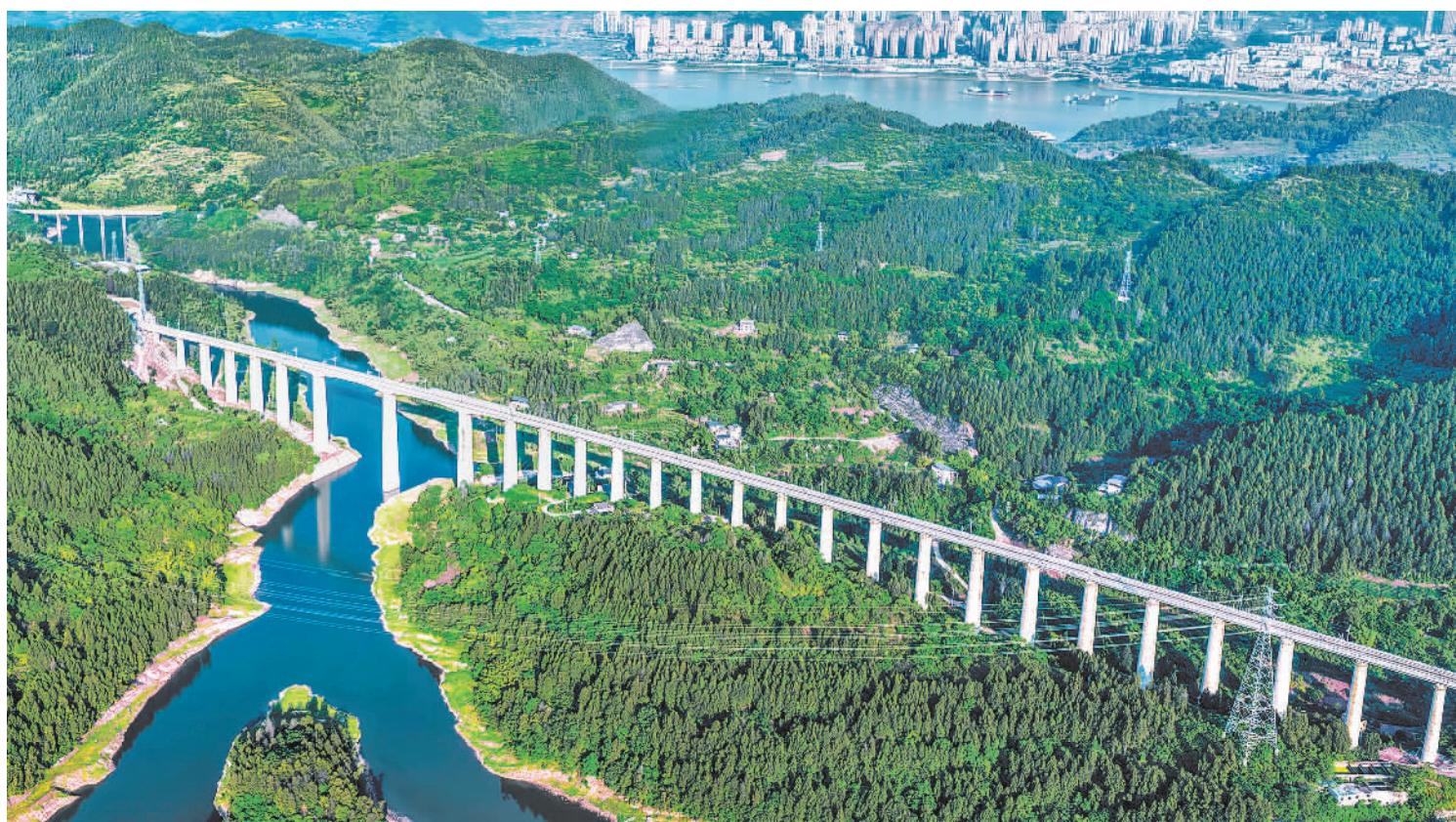
5月10日,位于重庆市丰都县的渝万高铁长田湾双线特大桥。
