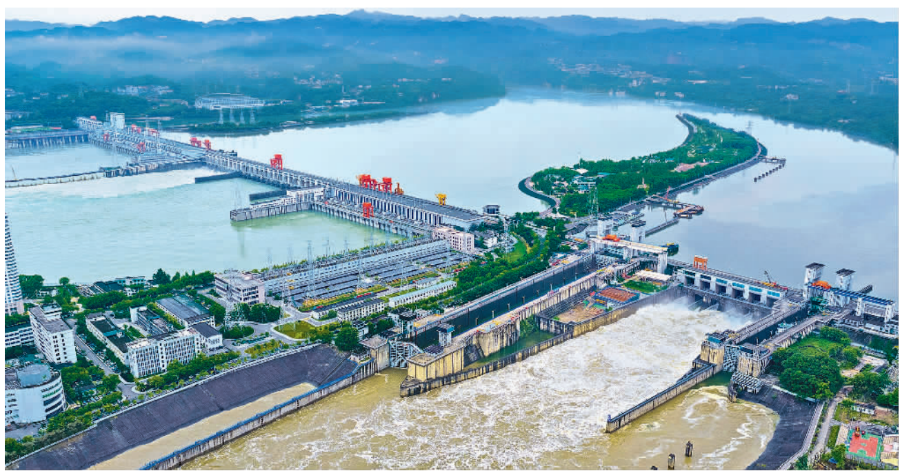
5月28日，位于湖北省宜昌市的葛洲坝水力发电厂分5档开启葛洲坝三江冲沙闸进行冲淤试验。此次冲淤作业将有效疏通通航水域，对保障航道安全畅通具有重要意义。王 耿摄(中经视觉)
