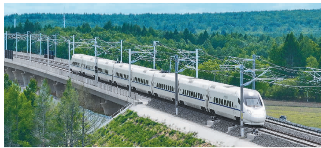
6月1日,我国最北高铁哈伊高铁首次开行动车组测试列车,为后续线路开通运营提供重要技术保障。通车后,哈尔滨至伊春的运行时间将由7小时压缩至2小时以内。 管一仑摄(中经视觉)
